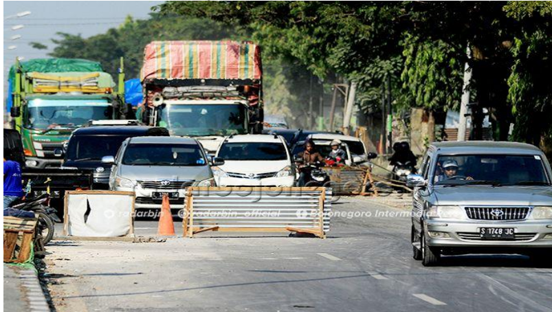
Gambar 2. Pola pengaturan lalu lintas sistem buka tutup di ruas Jalan Pucuk-Babat
