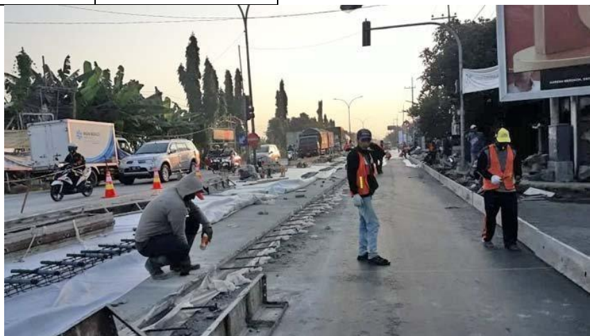
Gambar 1. Pelaksanaan proyek jalan ruas Pucuk-Babat menggunakan perkerasan beton ( rigid pavement ).
